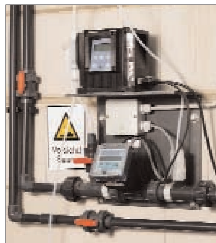
Dávkovací zařízení kyseliny v závislosti hodnoty pH
