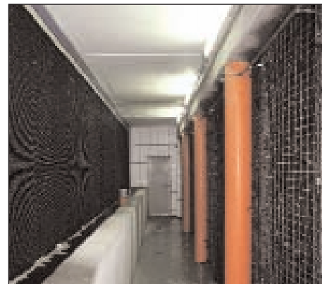
Ve třetím filtračním stupni, který je složen z kořenů dřevin, probíhá mikrobiální přeměna pachových látek.
