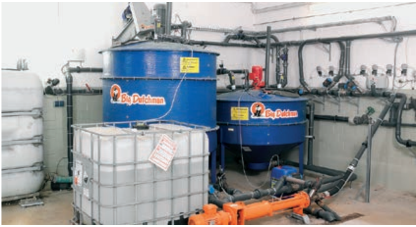
Zařízení s 1 nádrží a váženým tankem na použitou vodu
